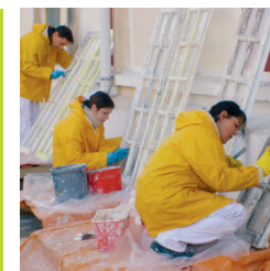
PEINTURE REVÊTEMENTS MURAUX
